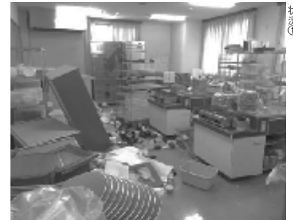
3階調理実習室食器棚やオープンなどが倒れた状況①
