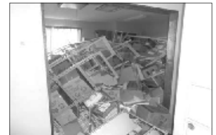
書類棚が倒れた状況
